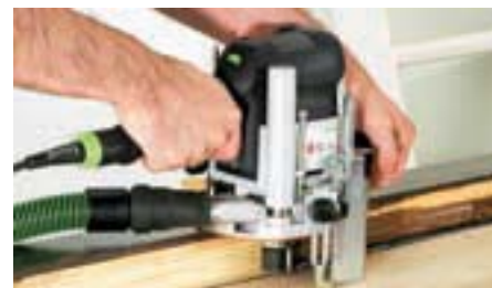
Остатки клея и уплотнителя могут быть удалены почти полностью перед установкой изолирующих стекол.
