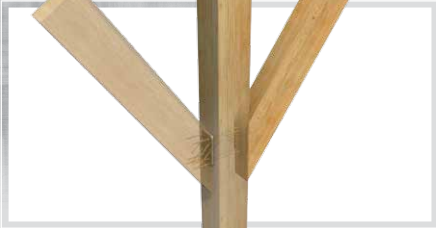
СОЕДИНЕНИЕ ПОДКОСОВ С ВЕРТИКАЛЬНОЙ СТОЙКОЙ
